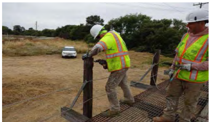
Las cuadrillas repararon la barandilla del cable del puente del río Pájaro.
