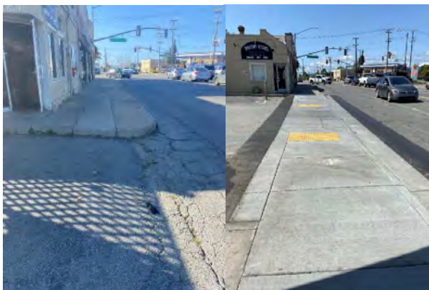
Izquierda: reemplazo de aceras (antes y después), Ciudad de Watsonville
