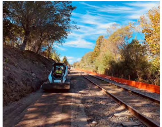
Tramo 7, Construcción Fase II, Ciudad de Santa Cruz.
