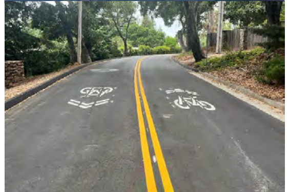
Rehabilitación del pavimento en Bean Creek Road (antes y después), ciudad de Scotts Valley
