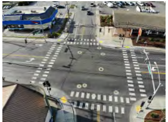
Elementos completos de calles en Freedom Boulevard, ciudad de Watsonville
