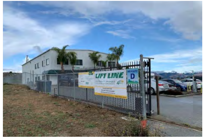
Instalación de Lift Line en Watsonville
