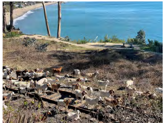
Se utilizaron cabras para realizar el control de la vegetación en la vía férrea.
